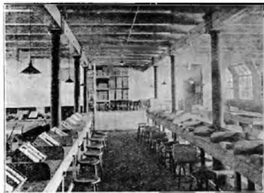
Op de 3e verdieping: eenige van de lange tafels. In dit lokaal vindt de eigenlijke fabriek van het element plaats.
