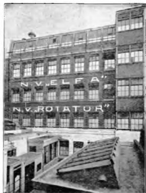
De achterzijde van de fabriek, links op den voorgrond de ingang naar het electr. laboratorium, rechts het kantoor.
